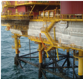
Special construction on K14-FA1 platform Aardolie Maatschapij B.V., NL
